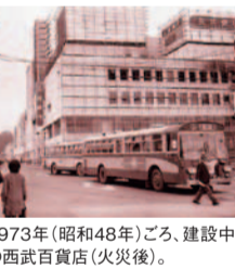
1973年(昭和48年)ごろ、建設中の西武百貨店(火災後)。
