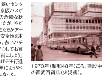
1973年（昭和48年）ごろ、建設中の西武百貨店（火災後）。
