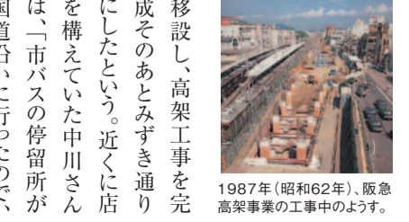
1987年（昭和62年）、阪急高架事業の工事中のようす。
