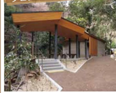
休憩所は、紅葉の景色が楽しめるように角度を調整。打ち放しのコンクリートの壁は木目加工を施し、自然の中になじむ工夫も。
