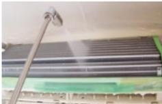
十分な洗浄をするためには十分な分解が必要。時間が掛かってでも出来る限りの部品を取り外して作業する。
