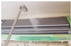
十分な洗浄をするためには十分な分解が必要。時間が掛かっても出来る限りの部品を取り外して作業する。
