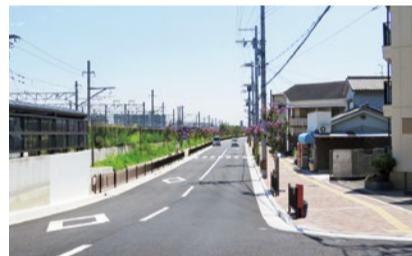
以前は一車線だった狭い道が、写真のように歩車分離の安全で快適な道へと生まれ変わった。
