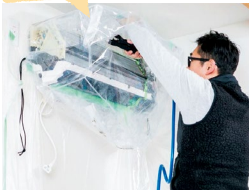
(上) 部屋が暖まらない原因はエアコンの汚れの可能性も。お困りの方は試す価値あり!
