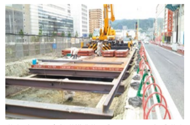
道路を掘り下げ、鉄道構造物を設置するために仮設道路用の鉄板を設置している様子(写真:箕面市HPより)。
