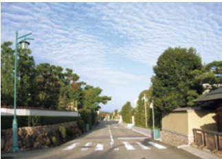
無電柱化されている山手幹線沿い(上)と六麓荘町(下)。
