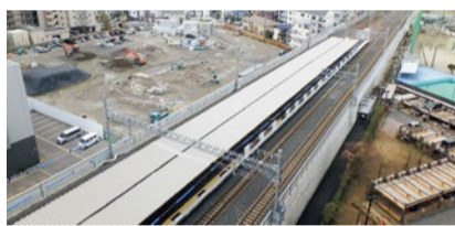
1月15日現在のJR総持寺駅、上空からの様子。
