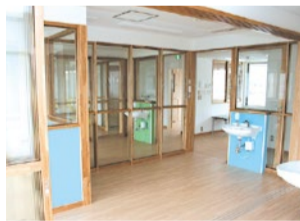
5つの個室が設置され、そのうち2つは入室児童の病状等に応じて大部屋にも変更できる仕様になっている。
