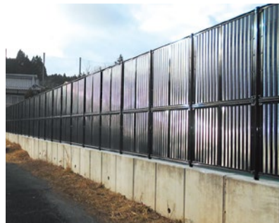
ブロック塀を撤去し、フェンスが新設された高槻市内の小学校。
