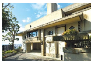
工事を終えたヨドコウ迎賓館の外観。
