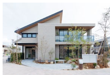
片流れ屋根とフラット屋根を組み合わせた豊かな表情を生む。
