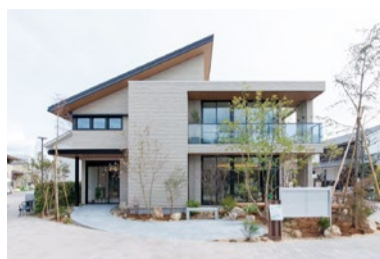
片流れ屋根とフラット屋根を組み合わせた豊かな表情を生む。
