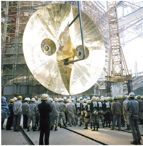
初代「黄金の顔」は直径10.6メートルで、重さは鉄製フレームを含めて約12トン。写真提供:大阪府
