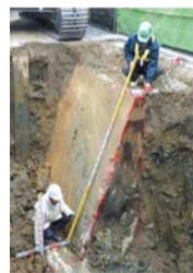
基礎杭施工箇所の地下から出現した昔のコンクリート擁壁。宇川から千里川の間での撤去作業に時間を要するため延長。
