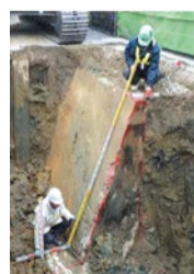
基礎杭施工箇所の地下から出現した昔のコンクリート擁壁。芋川から千里川の間での撤去作業に時間を要するため延長。
