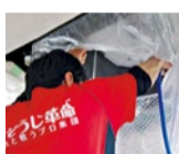
エアコンを分解し、エコ洗剤を使用。高圧洗浄で洗い流し、内部に潜むカビやほこり・花粉を除去。
