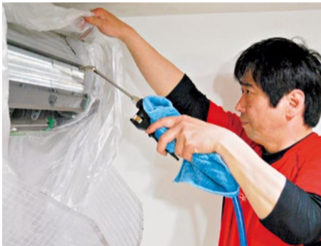
エアコンを分解し、エコ洗剤を使用。高圧洗浄で洗い流し、内部に潜むカビやほこり・花粉を除去。
