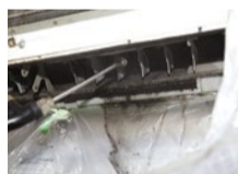
エアコンを分解し、エコ洗剤を使用。高圧洗浄で洗い流し、内部に潜むカビやほこり・花粉を除去。
