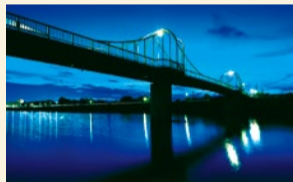
安威川歩道橋/摂津市
