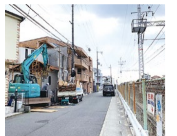
建物の取り壊しが順次行われています。
